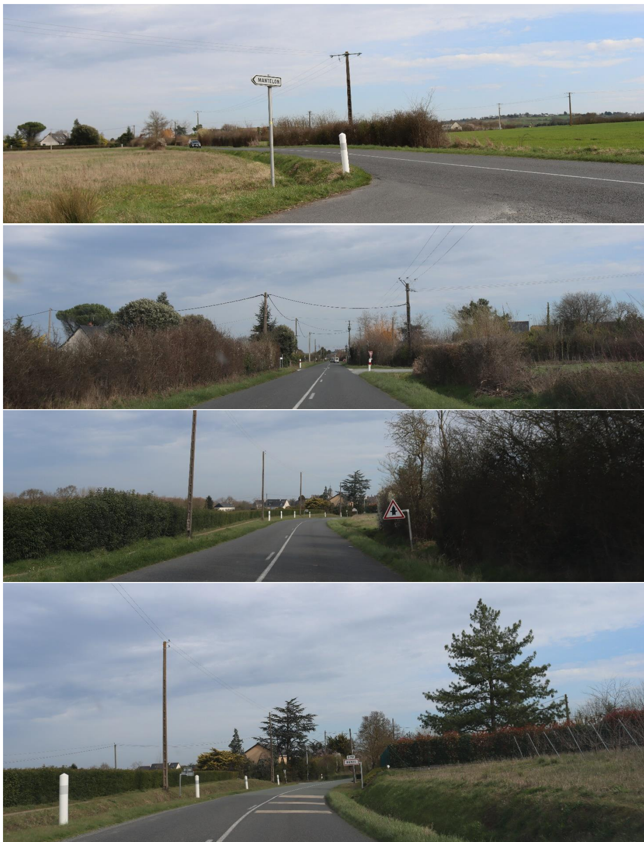
Photo 18. Entrée Ouest (D751)
