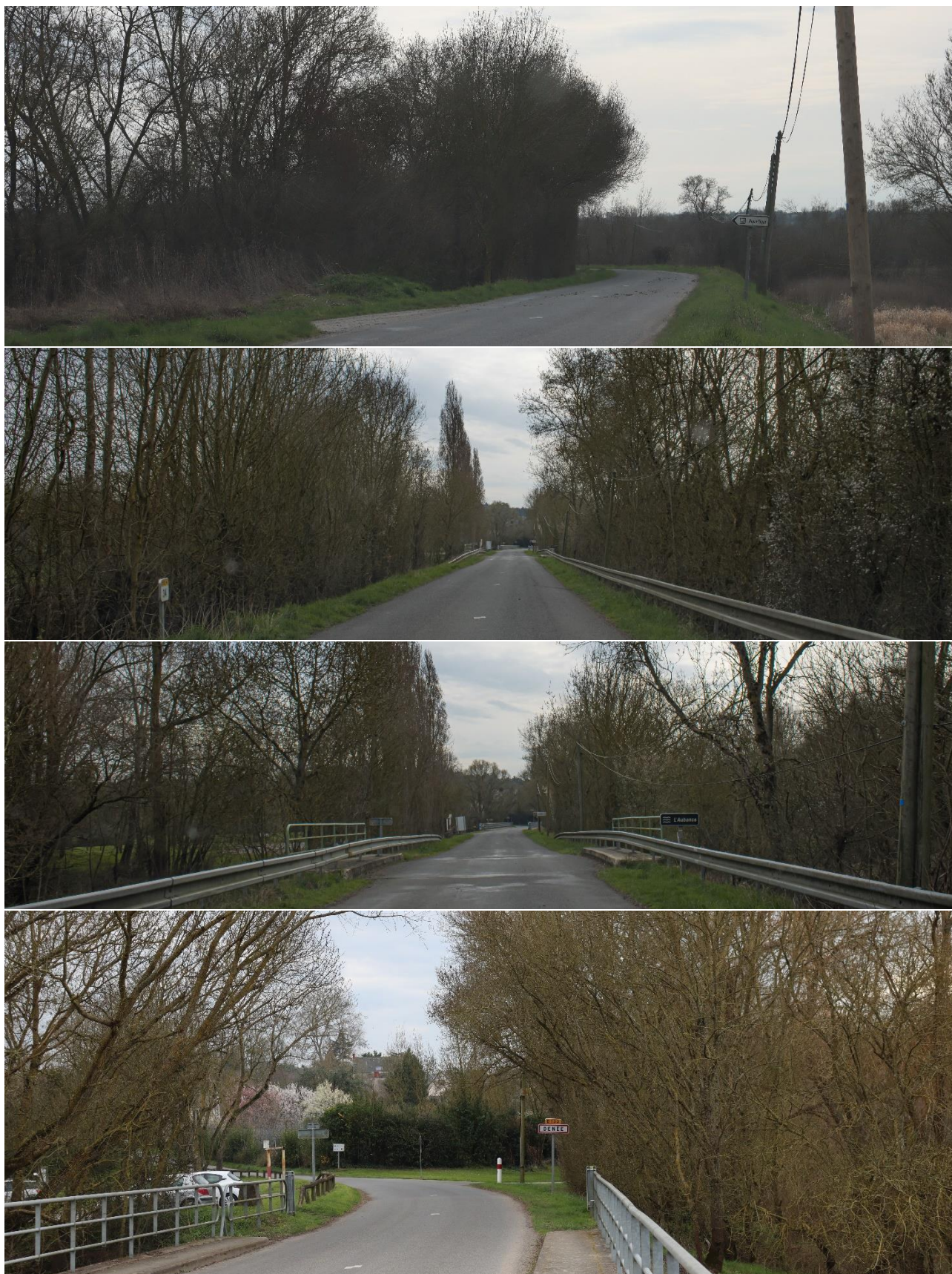
Photo 17. Entrée Nord (D132)
