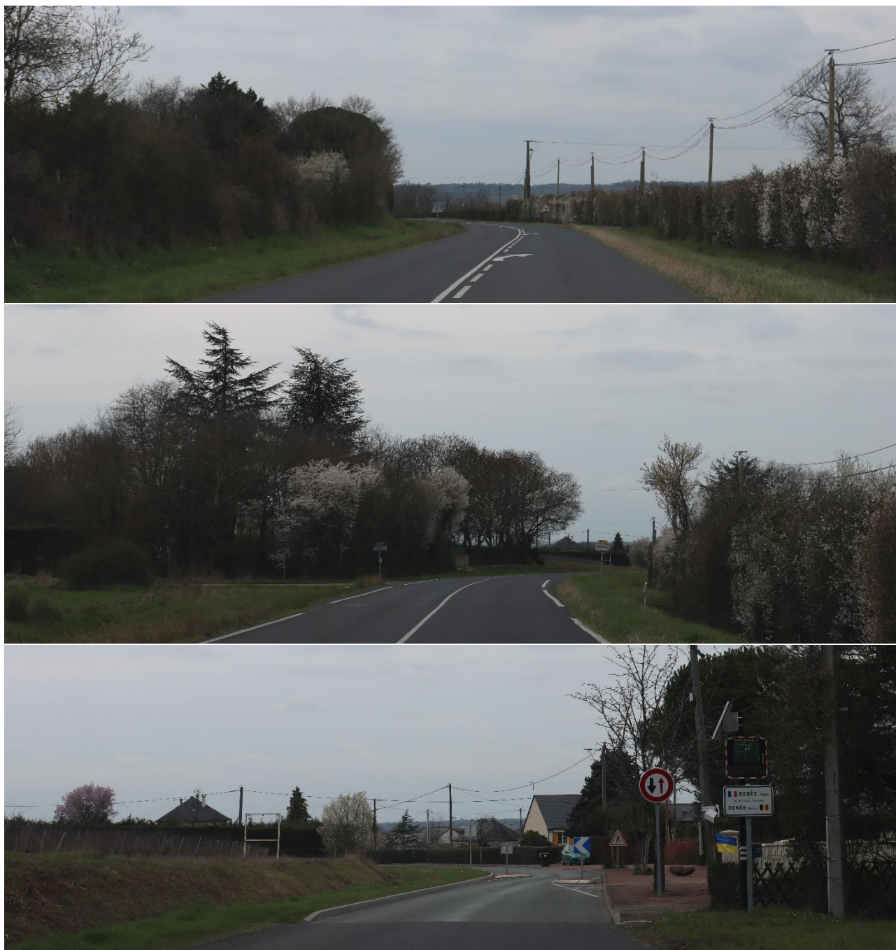
Photo 19. Entrée Sud (D123)
