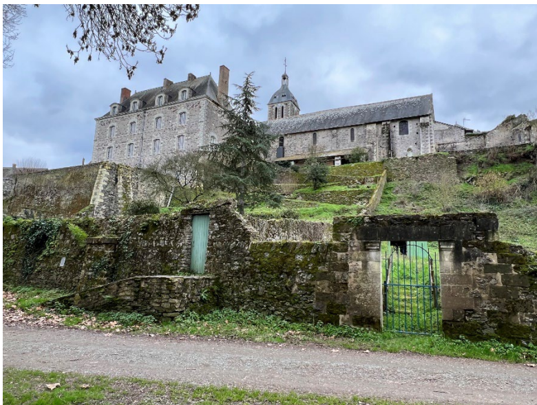
Vue depuis le chemin sous les murs © BE-AUA
