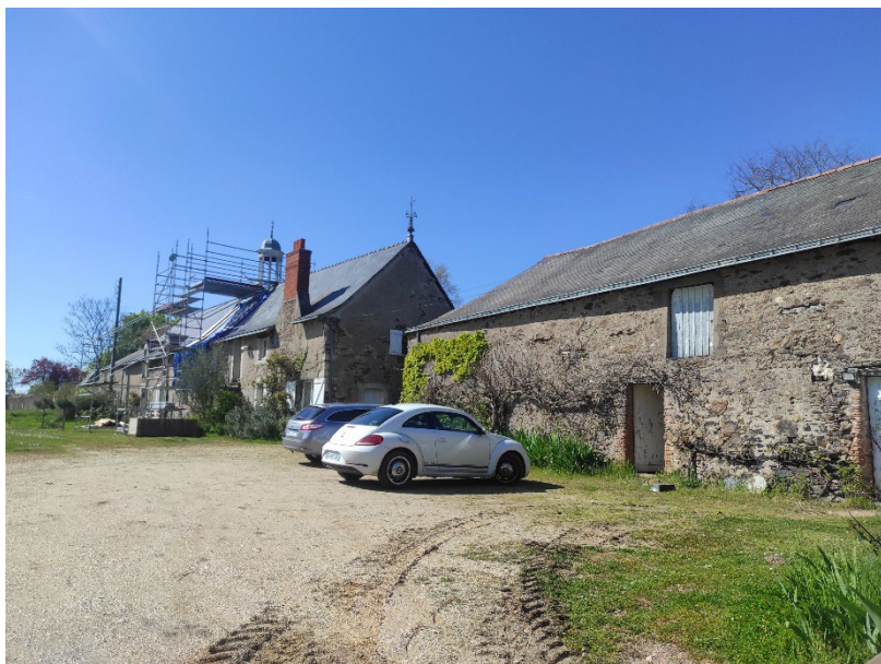
Cour avec les annexes © BE-AUA
